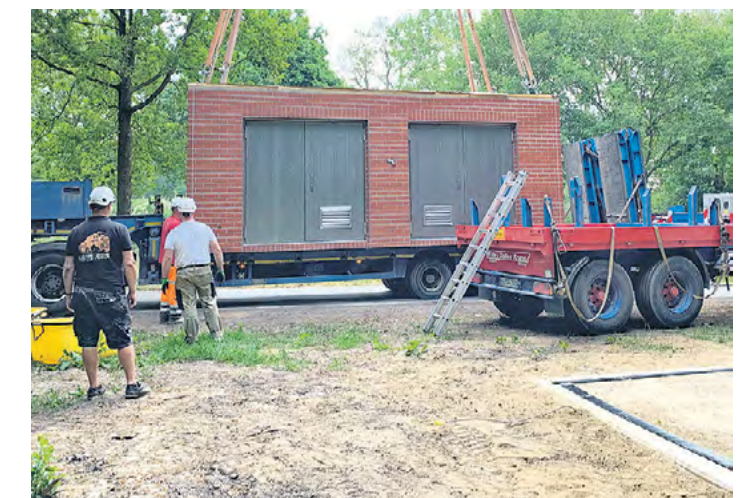
Die neue Druckerhöhungsstation kommt hier in Welmbüttel an. Foto: WVND
