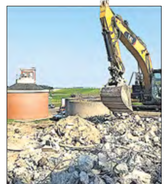
Großer Umbau auf der Kläranlage Büsum.
