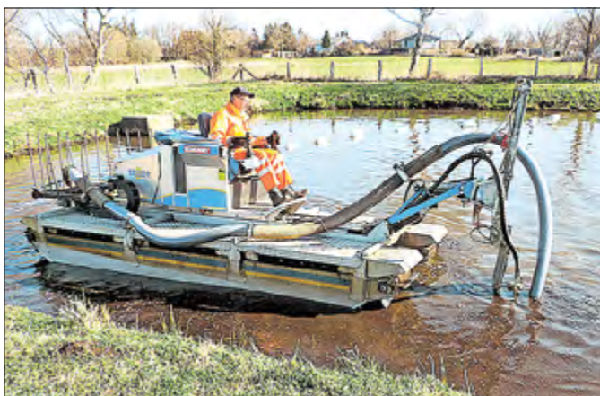
Ausgeklügelte Technik kam auch bei der Entschlammung des Klärteiches in Barkenholm zum Einsatz.
