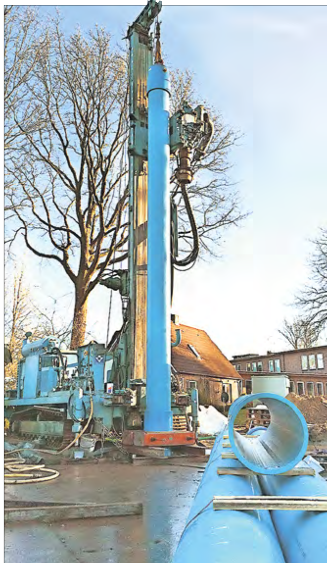
Schwere Technik ist nötig, um den Bohrkopf bis in 100 Meter Tiefe zu bringen.
