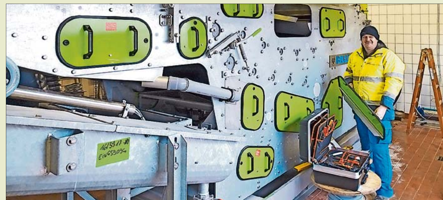
Vor seiner Abfuhr wird der Schlamm entwässert und damit deutlich im Volumen reduziert. Auf der Kläranlage Lohe-Förden kümmerte sich Mitarbeiter Dennis Jacobs im Februar um den Aufbau der neuen Schlammpresse.
