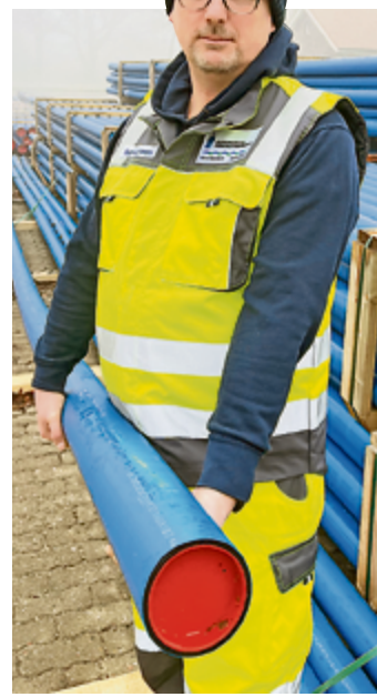
▲ Die blauen Kunststoffrohre werden beim WVND regelmäßig verbaut. Frank Volkmann ist der Neue im Team, das dafür im Verbandsgebiet im Einsatz ist.
