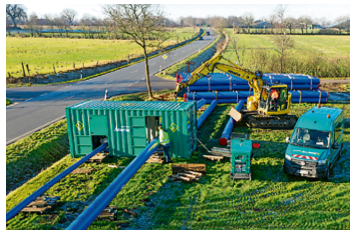
▲ Hier wird nicht gekleckert, sondern geklotzt. Im oberflächenschonenden Verfahren verlegt der WVND derzeit neue Leitungen in der Nähe seines Wasserwerkes Linden.
