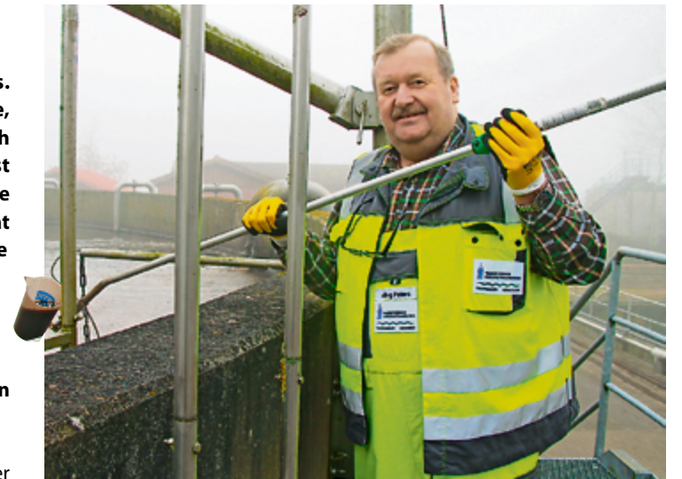
▲ Viele Prozesse laufen auf Kläranlagen automatisch ab. Der genaue Blick der Fachleute, hier Jörg Peters auf der Kläranlage Lehe, gehört jedoch unbedingt dazu.
