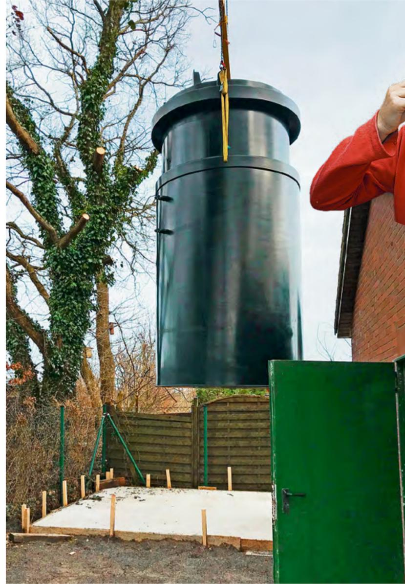
◀ Mit diesem Tank am Hauptpumpwerk in Hohn wird Eisen-II in den Kanal dosiert, was den übel riechenden Schwefelwasserstoff bindet. Foto: WVND
