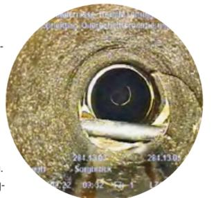
Das hat die Kamera entdeckt: Ein fremdes Rohr geht mitten durch den Kanal. Ein Knackpunkt, denn hier kann das Abwasser nicht mehr ungehindert abfließen. Foto: WVND
