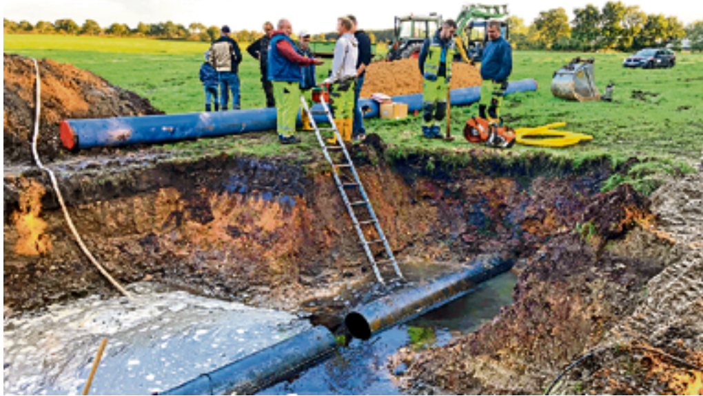
Die Reparatur der beschädigten Rohre musste koordiniert und schnell erledigt werden.
