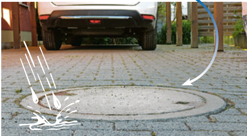
... direkt zu einer unterirdischen Zisterne weiter, die etwa unter Ihrer Einfahrt dezent „versteckt“ werden kann. Ausgestattet mit einer elektrischen Pumpe kann das aufgefangene Wasser – so es nicht versickert – sogar in Trockenzeiten für die Bewässerung des Gartens genutzt werden. Beachten Sie: Pumpen erfordern regelmäßige Wartung!
