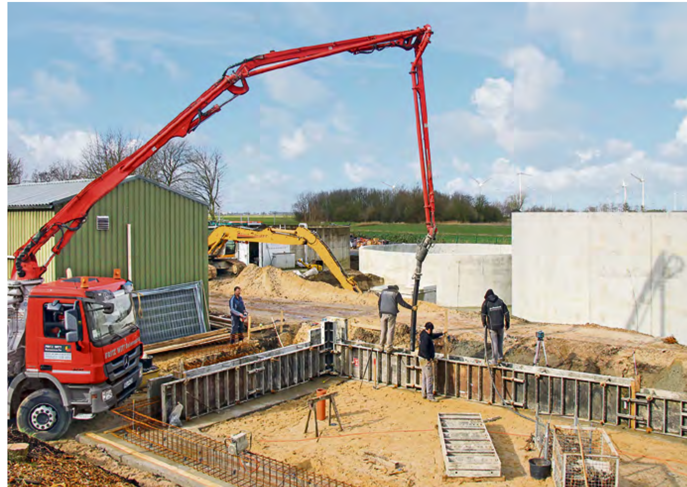
Die runden Behälter für die Reaktoren stehen im Rohbau schon, als das Fundament für das neue Maschinen- und Betriebsgebäude gegossen wird.
